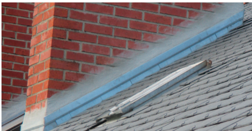
Souche de cheminée*
