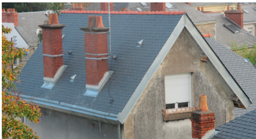
Toiture d'isolation par l'extérieur*
