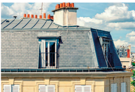
Toit à la mansard
