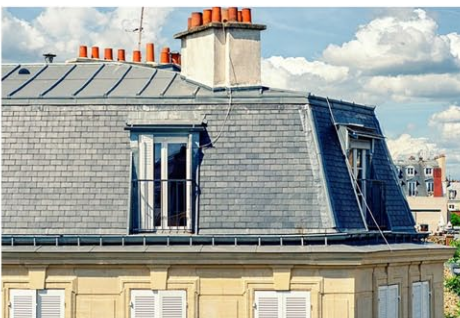
Toit à la mansard
