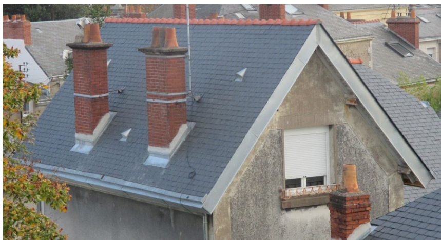
Toiture d'isolation par l'extérieur*
